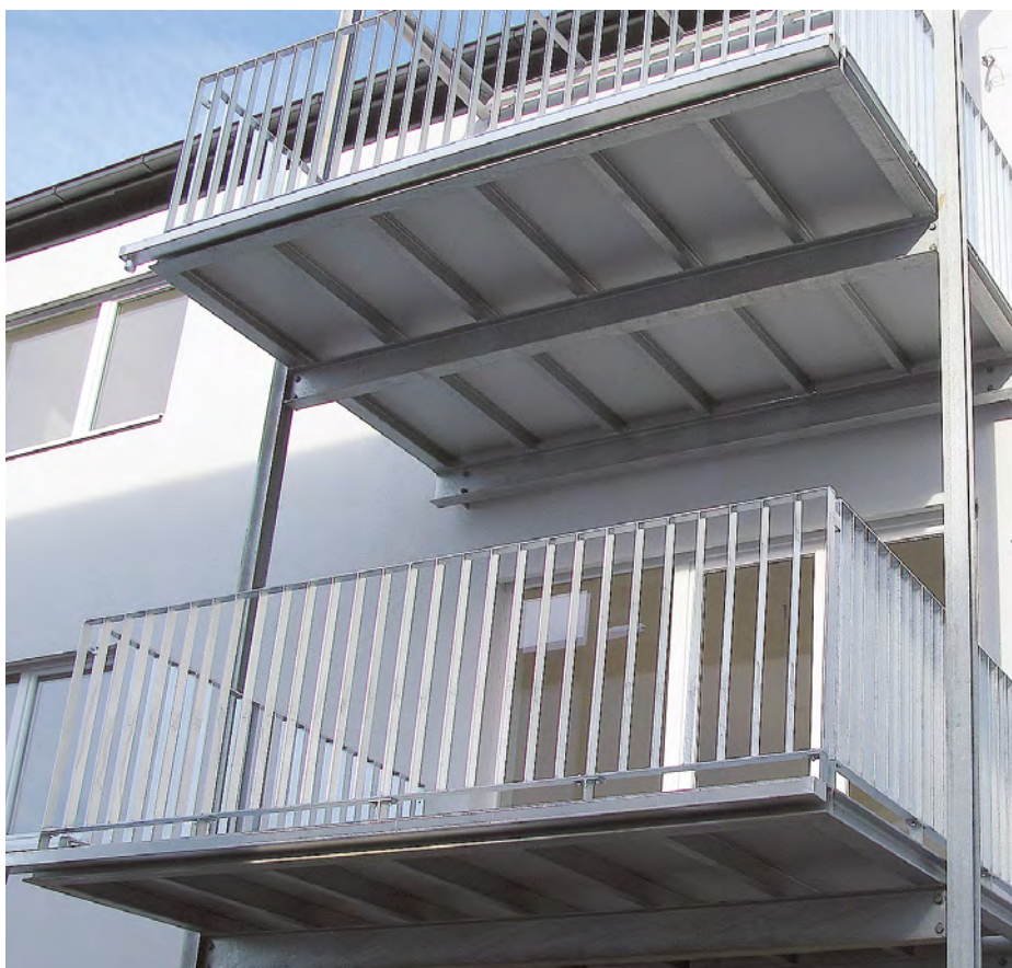
BALKONBODENPLATTE OBJEKT ST. VEIT/GLAN, ÖSTERREICH
